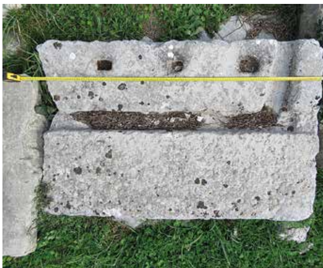
Slika 23. Kamena ploča sa žlijebom za olovnu cijev južno od Castel- luma 1 (foto: K. Marasović)
